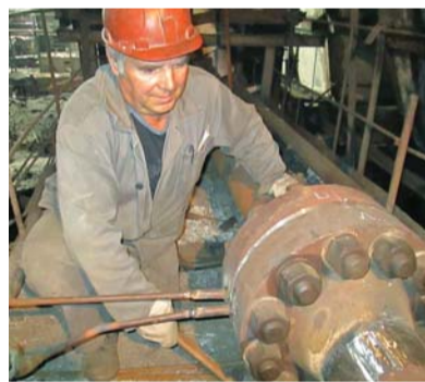
Иван Грунский, слесарь 6 разряда ЦРКО, производит замену расходомерной шайбы на питательной магистрали котла №7
