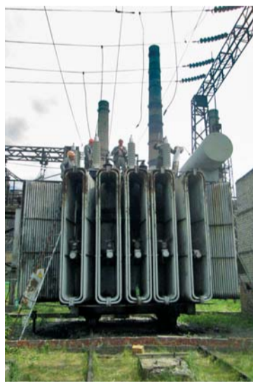
Работы на трансформаторе присоединения
