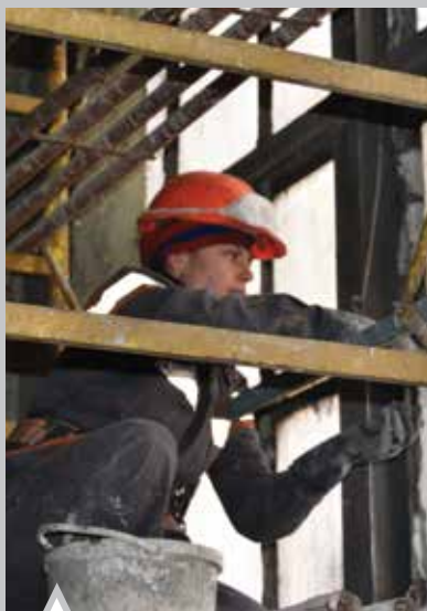
Маляр РСЦ Оксана Ляшко выполняет обмазку стекла в турбинном отделении
