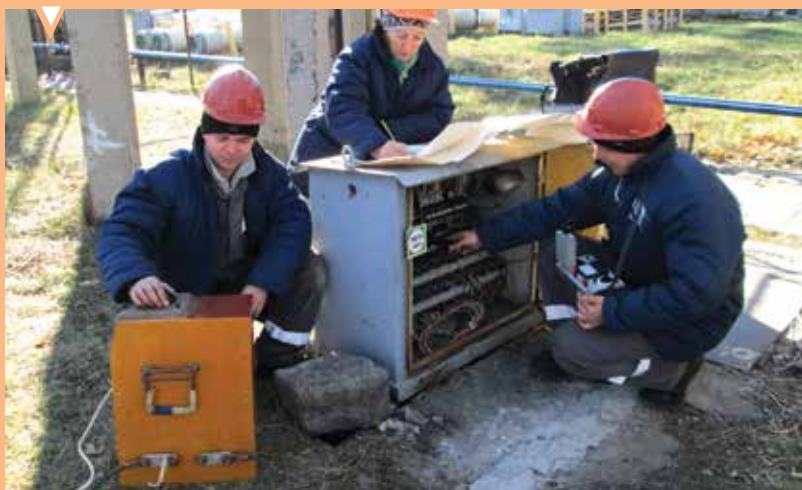
Ремонт поврежденного кабеля управления ВВ ВЛ 330 кВ «Майская»
