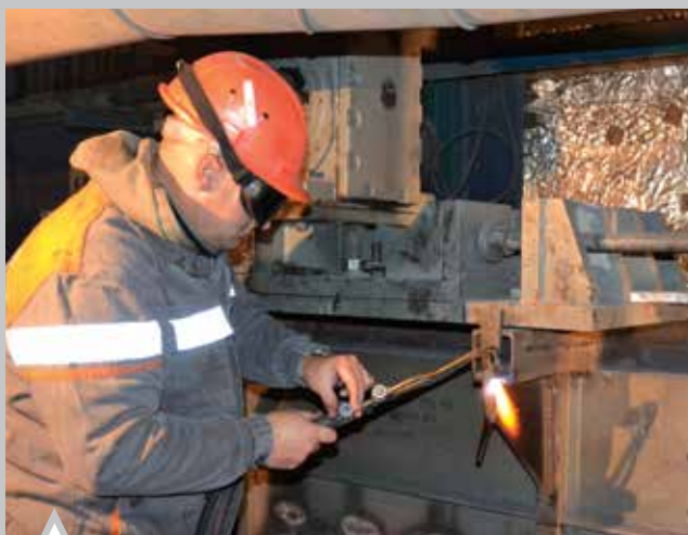
Слесарь Александр Коржов выполняет ремонт корпуса транспортера угля
