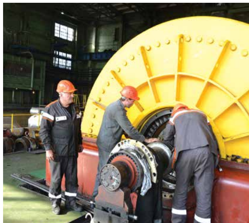
Слесари Григорий Прокопец, Виталий Булатов и Андрей Кольцов производят сборку масляных уплотнений генератора
