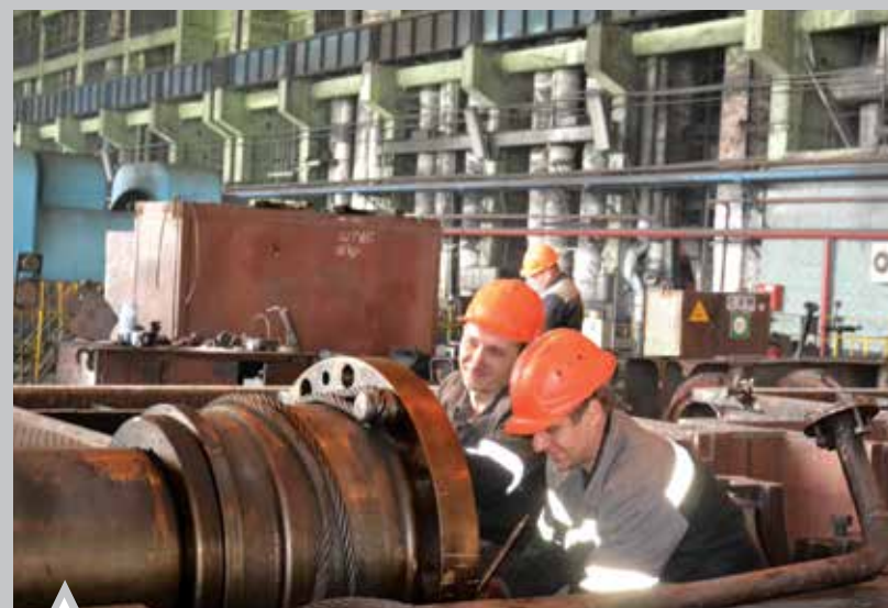
Слесари Александр Толкачев и Виталий Боженко выполняют ремонт ротора низкого давления турбогенератора №9
