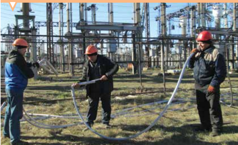
Обвязка опор под установку новых изоляторов
