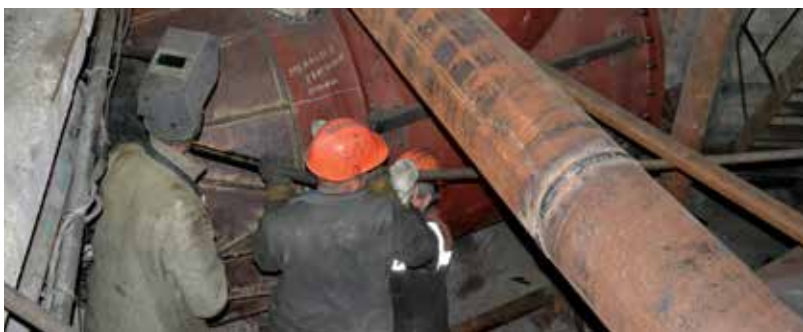
Перетрассировка дренажных трубопроводов маслосистемы турбогенератора №4 после монтажа филътра предочистки охлажденной воды: слесари Николай и Сергей Прокопенко, сварщик Владислав Фомичев.
