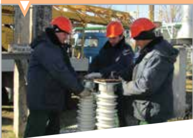
Подготовка изоляторов под установку
