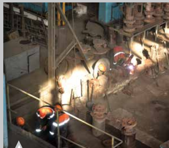
Ремонт кулачкового-распределительного устройства системы парораспределения цилиндра высокого давления турбогенератора №9
