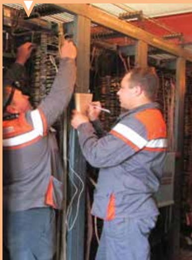
Ремонт поврежденного кабеля управления ВВ ВЛ 330 кВ «Майская»
