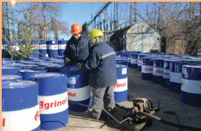
Перекачка трансформаторного масла в баки
