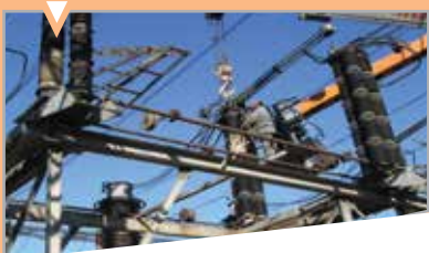
Замена поврежденных изоляторов ОРУ-220 кВ (разъединитель групповой 13АТ)
