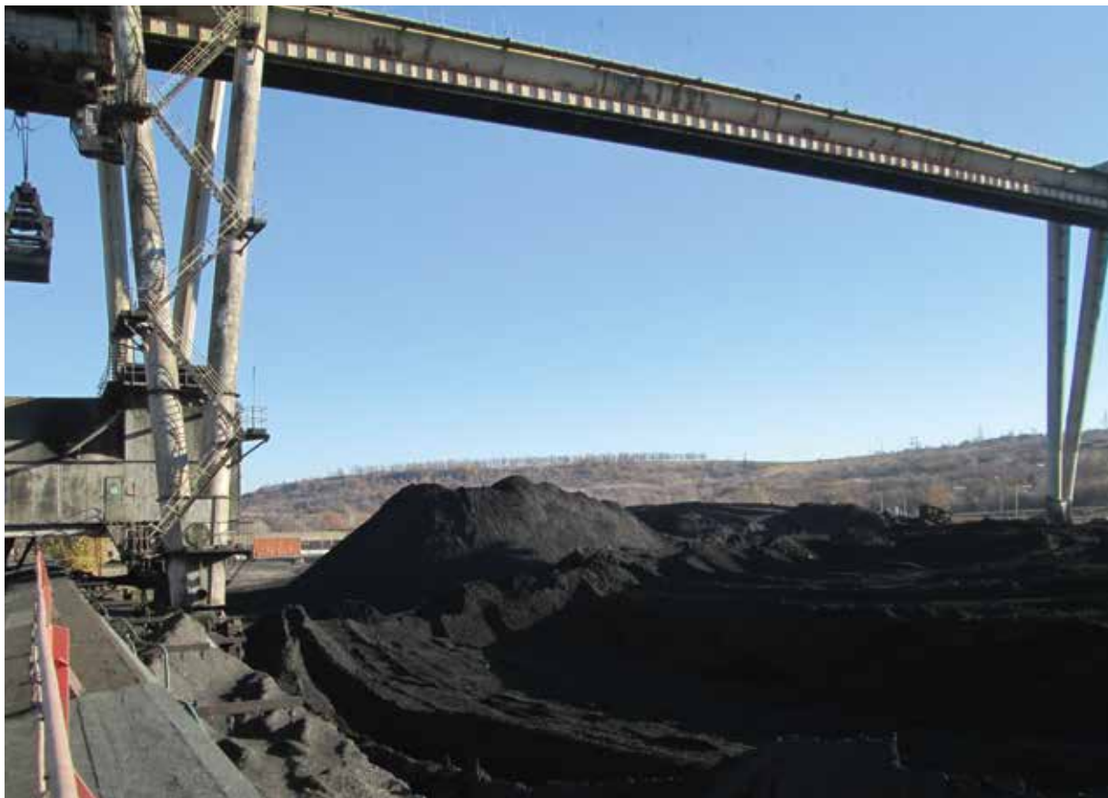
Угольный склад СлавТЭС. Пока без новых поступлений
