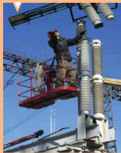
Монтаж разъединителей ОРУ-330 кВ (ШР первой системы шин)
