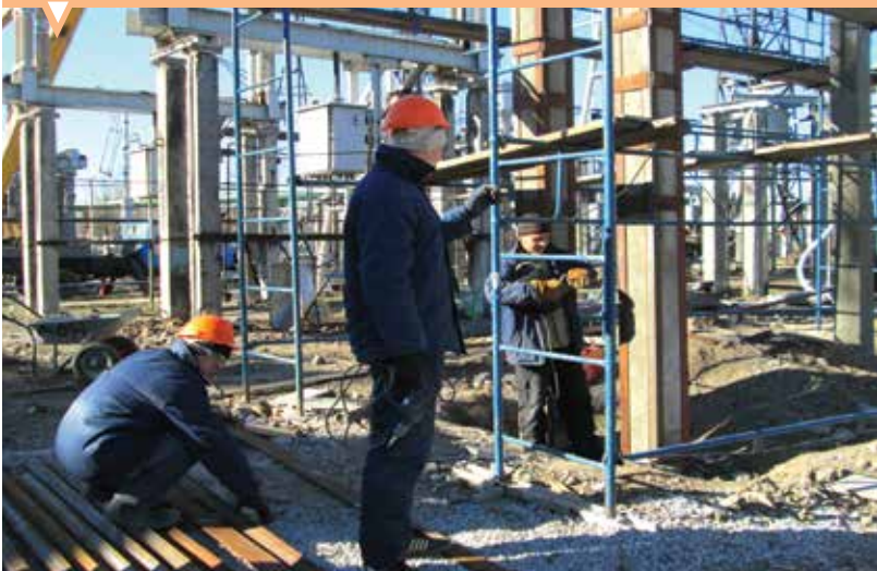
Подготовка изоляторов под установку
