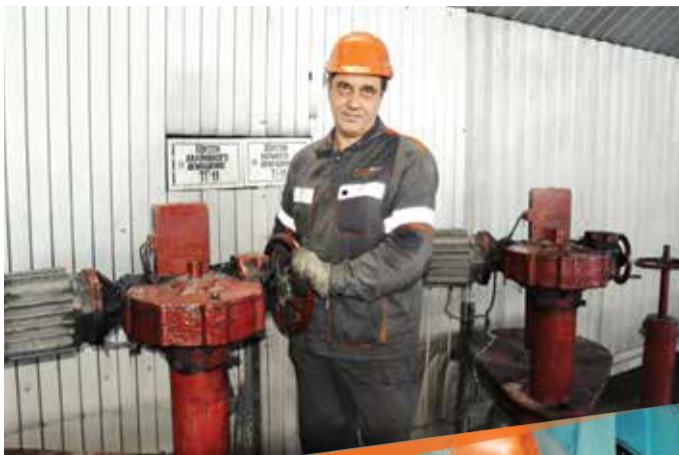
Главные паровые задвижки - проверка плотности закрытия
